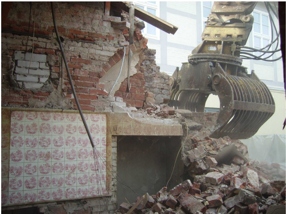
Kacheln, eine Nische, Bogen-Fragmente in der Außenwand: Der Abbruchbagger brachte manche Spuren einstiger Umgestaltungen zum Vorschein.
